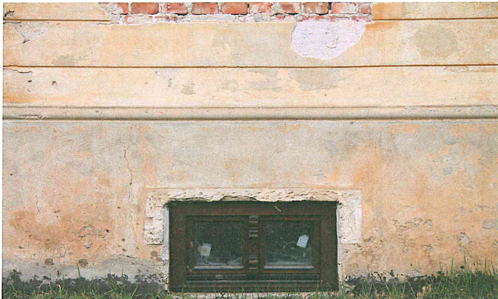
Fot. Nr 5 i 6. Willa AVE. Stan przed konserwacją.
