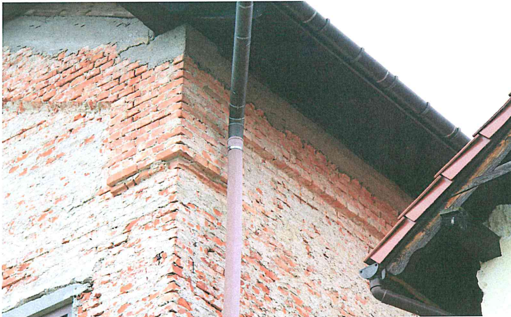
Fot. Nr 7 i 8. Willa AVE. Stan przed konserwacją.
