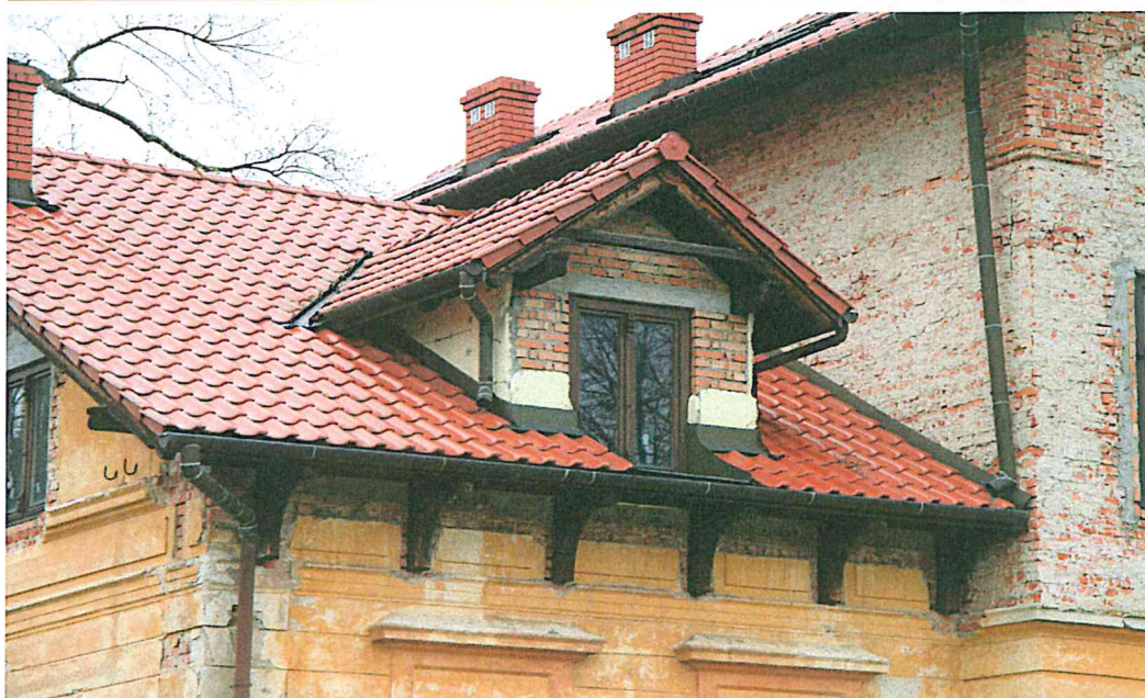
Fot. Nr 1 i 2. Willa AVE. Stan przed konserwacją.
