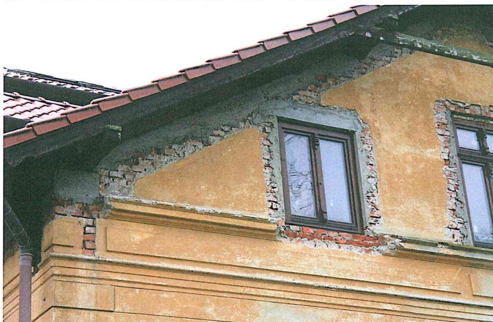
Fot. Nr 9 i 10. Willa AVE. Stan przed konserwacją.
