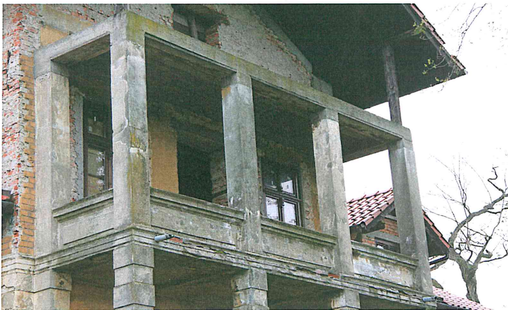
Fot. Nr 15 i 16. Willa AVE. Stan przed konserwacją.
