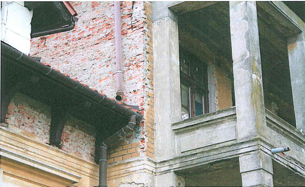
Fot. Nr 17 i 18. Willa AVE. Stan przed konserwacją.
