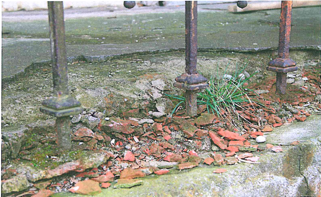
Fot. Nr 21 i 22. Willa AVE. Stan przed konserwacją.
