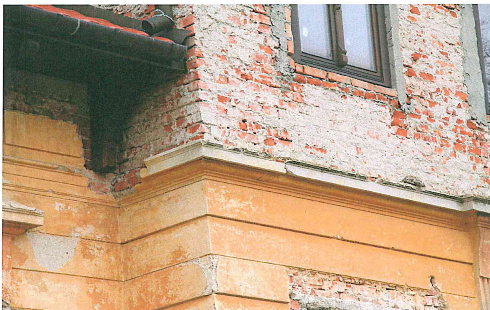
Fot. Nr 19 i 20. Willa AVE. Stan przed konserwacją.
