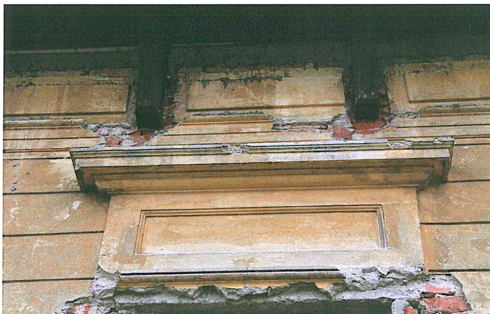
Fot. Nr 13 i 14. Willa AVE. Stan przed konserwacją.
